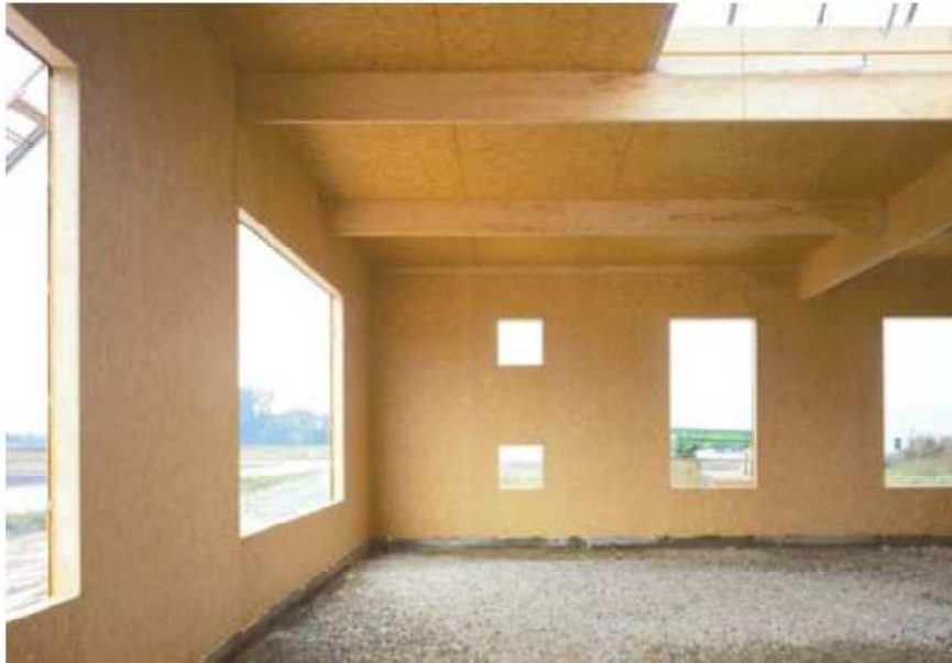
Capannone con costruzione leggera intelaiata – tamponamento interno in OSB
