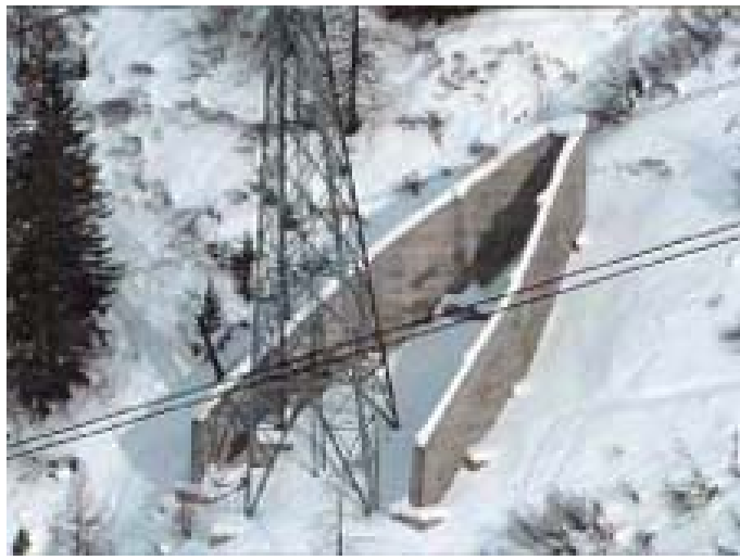
Figura 5 Opera di deviazione
