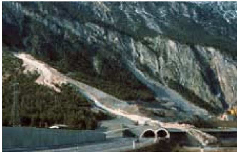
Figura 6 Galleria di protezione dalle valanghe
